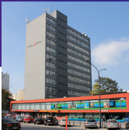
Kancelářský komplex Prometeon, Łódź 308 kW
